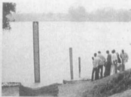
2 et 3. Afin de préparer les épandages de larvicides, le débit de chaque cours d'eau doit être calculé chaque semaine soit par lecture directe des échelles de crue, soit par l'intermédiaire d'un réseau de télétransmission en temps réel des hauteurs d'eau (télébaisses).
